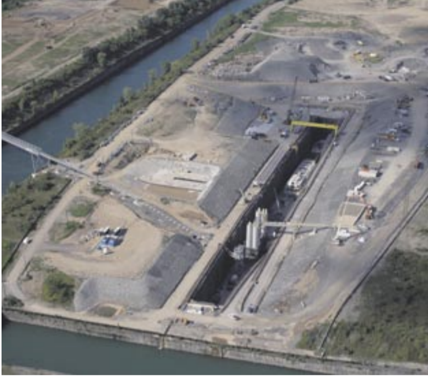
Strabag baut im Auftrag der Provinz Ontario einen 10,4 Kilometer langen Stollen. Fotos: Strabag
